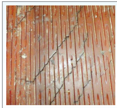
Figura 3: Trincas severas.
